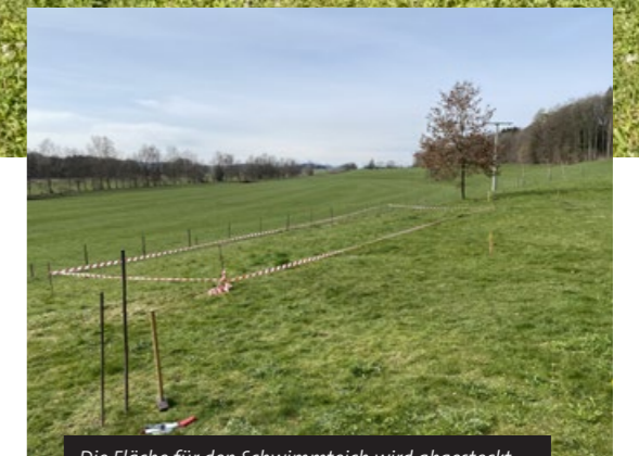
Die Fläche für den Schwimmteich wird abgesteckt – hier nimmt die Planung Gestalt an.
